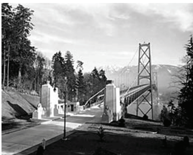
Vancouver, Lions Gate Bridge, inauguré en novembre 1938
